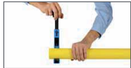
3. Cortar el tubo de forma totalmente recta.
