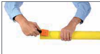
5. Rasar la zona de soldadura del tubo.
